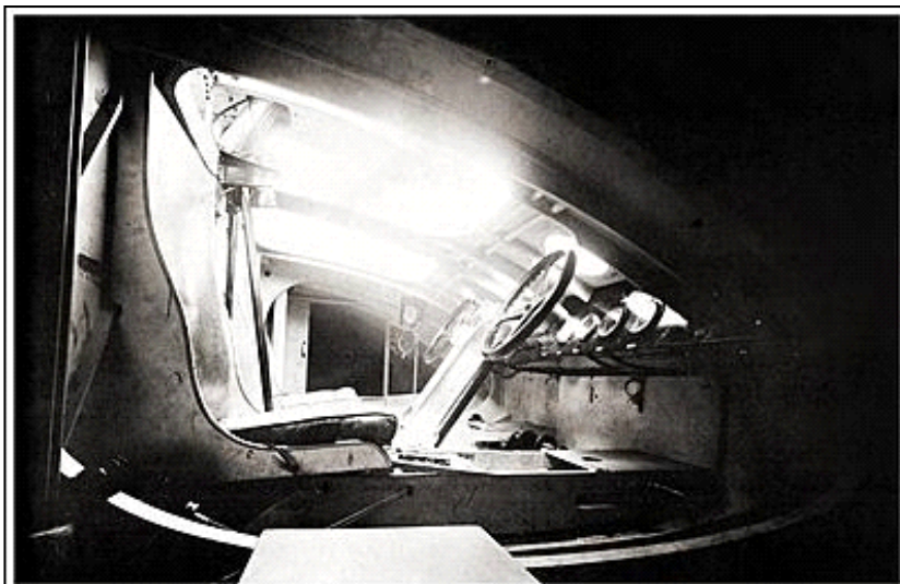
La strumentazione dell'S 55X. L'indicatore ottico di pilotaggio Nistri-Biseo è alla sinistra degli strumenti posti al centro. Era una specie di bussola-indicatore di rotta.
