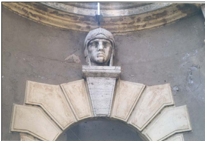
Un particolare della porta principale d'ingresso.
