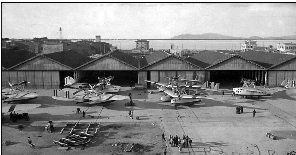
Gli S 55TA che parteciperanno alla Prima Trasvolata Atlantica di fronte agli hangar di ricovero.
