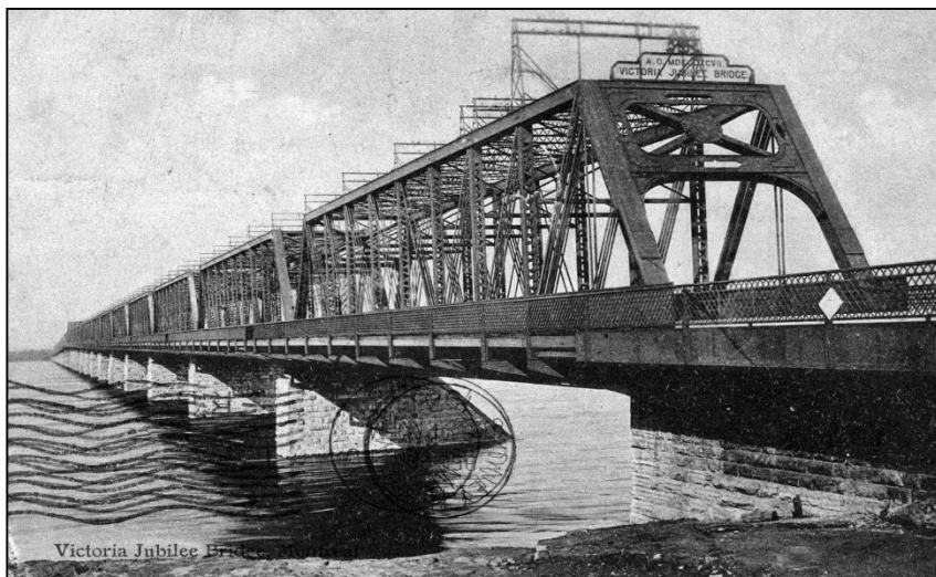
Il Victoria Bridge in una cartolina d'epoca. Costruito nel 1898-99 su progetto dell'ing. Joseph Nobson, completamente in ferro, poggia su 25 piloni. Il suo costo era stato di venti milioni di dollari.
