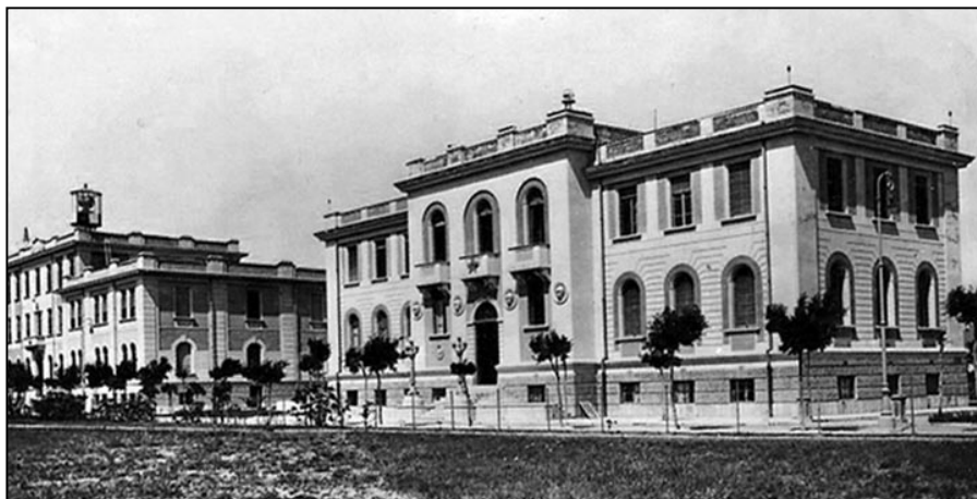
La palazzina comando, dove aveva sede la scuola NADAM.
